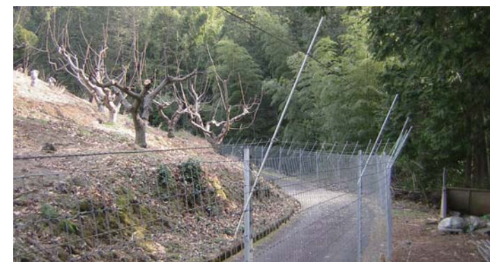
サル対策①（フィールドフェンス H1500+しのび返し支柱システム）
