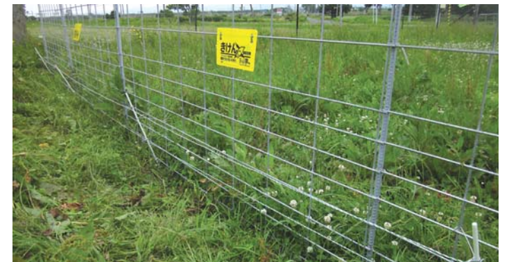
イノシシ対策②（ワイヤーメッシュ+しのび返し支柱システム）
