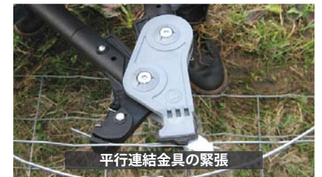
平行連結金具の取付け
