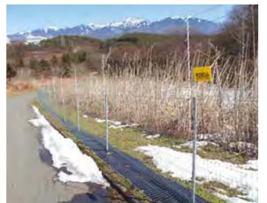
知能や身体能力が高いサルの侵入を防ぐには、フィールドフェンスと「**しのび返し支柱システム**」を併用することで、防除することが出来ます。「**しのび返し支柱システム**」は上に出すように設置することで、より心理的効果を高めます。場合によっては、段数を増やしたり、プラス線とマイナス線を同時に触るように設定することで、さらに効果を高めることが出来ます。但し、近くに電柱や木があればそこから簡単に侵入を許してしまいます。設置場所は周辺環境に十分配慮し、場合によっては、伐採などが必要になることもあります。
