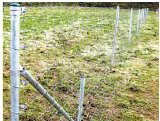
全国各地で被害が見られるイノシシは、鼻先で器用にモノを探っていく習性を持っています。最近ではその鼻でフェンスを持ち上げたり、掘り起こしたりして侵入するというケースが多くなっています。掘り起こし対策をする場合は、フェンスの下部が自由に折れ曲がる「**イージーベンダーフェンス**」が有効です。折れ曲がった部分はペグなどを使って止めることで、さらに強力なフェンスに仕上がります。
