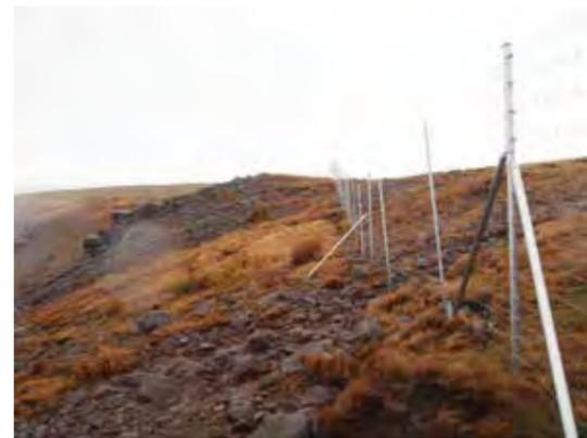
跳躍力の高いシカの侵入を防ぐには、フィールドフェンスの高さを2m以上に設定するのが基本です。また、低いフェンスの上部に「**しのび返し支柱システム**」を用いて電気柵をプラスすることで、低かったフェンスでもシカに対応することが出来ます。
